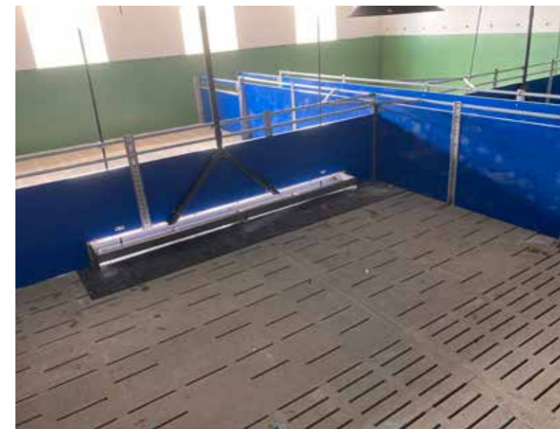
Blick in den neuen Ferkelaufzucht- und Mastschweinestall.
